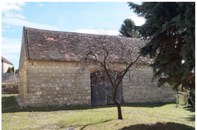
Stadl nach Renovierung
