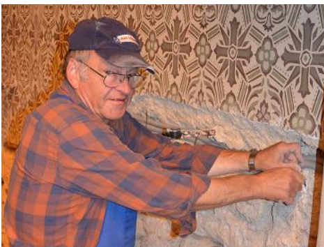
Johannes Glavanovits erneuerte die elektrische Leitung im Altarraum, die durch die Stemmarbeiten in Mitleidenschaft geraten war. Somit ist alles fürs Verputzen vorbereitet .
