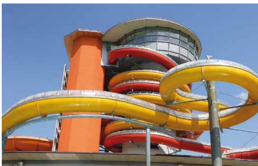
■ Projekt ReLEE: Energiebedarfsanalyse bei den Rutschen der Sonnentherme Lutzmannsburg
