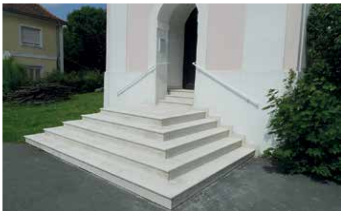
Erneuerung der Stufen beim Eingang zur alten Pfarrkirche
