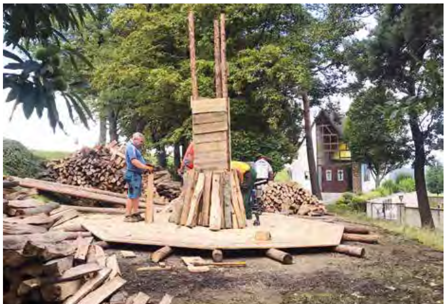
■ oben: Gewusst, wie – der Aufbau eines Kohlenmeilers
