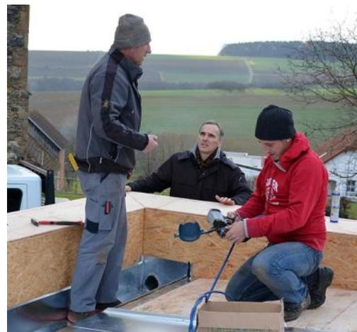
Rechtzeitig vor dem Wintereinbruch errichtete die Spenglerei Reiter auf dem undicht gewordenen Flachdach des WC hinter der Kirche ein **verblechtes Pultdach**, das auch vom Bundesdenkmalamt genehmigt wurde. Hier Mag. Adam bei der Besichtigung. Nach der Kernbohrung für den Abfluss wurden Dachstuhl und Holzvertäfelung der Steinmauer gemacht und schließlich kam die Abdeckung mit verzinktem Blech darauf.
