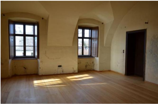
Die **Renovierungsarbeiten des Pfarrhauses** in Bernstein gingen zögernd voran, aber schön langsam ist ein Ende in Sicht. Die groben Arbeiten innen und außen sind fertig. Die Ostseite ist verputzt und die Drainage abgeschlossen. In der ehemaligen Kanzlei ist der Fußboden neu verlegt und versiegelt, die Innenflügel der Fenster sind noch zu erneuern. Die Malerarbeiten werden abschließend in Eigenregie gemacht.
